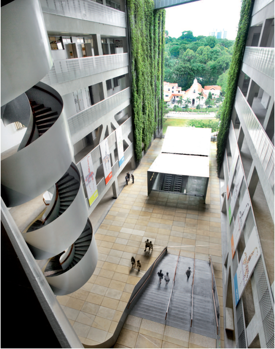
SOTA, School of Arts, Singapore. WOHA Architects, Singapore. The building is designed with open facades and natural breezeways on all upper levels. The class rooms are designed according to principles of adaptive comfort with natural cross ventilation and elevated air speed. Measurements revealed good comfort and an excellent user acceptance of the building. The building is a role model for adaptive comfort design as well as for the new campus building of the BRAC University Dhaka, Bangladesh. Photo Credit: Patrick Bingham-Hall. Sota, école d'arts à Singapour. Conçue par Woha Architecture à Singapour. Le bâtiment est conçu avec des façades ouvertes et des voies de ventilation naturelles à tous les niveaux supérieurs. Les salles de classe sont conçues selon les principes de confort adaptatif avec une ventilation naturelle et une vitesse élevée de l'air. Les mesures ont révélé un bon confort et une excellente acceptation par les utilisateurs du bâtiment. De même que l'université BRAC Dhaka au Bangladesh, ce bâtiment est un modèle du genre dans l'esprit de la conception du confort adaptatif.
